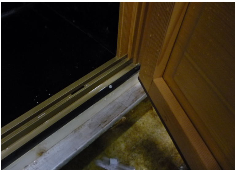
Détail liaison ouvrant / dormant
